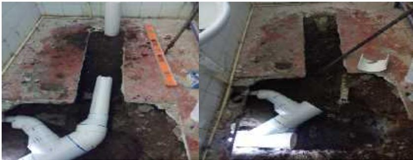
**Se terminó de conectar el drenaje del primer baño y se rellenó y se le echo sementó para resanar lo que se trono.**
